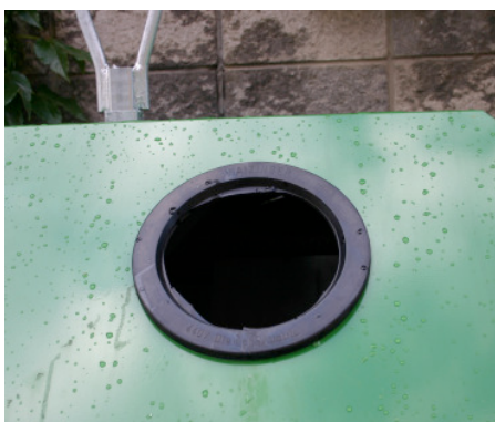
Zerstörte Deckel – weniger Lärmschutz
